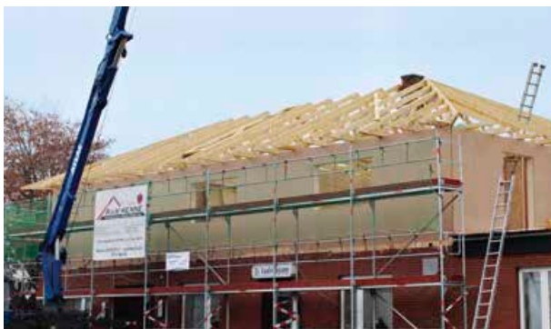
▲ Haus auf Haus: Aufstockung mit einer Holzrahmenkonstruktion und einem Dachtragwerk aus Nagelplattenbindern
