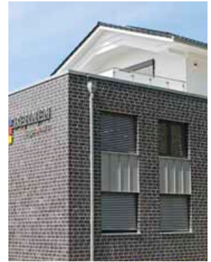
▲ Aufstockung mit Scherenbindern in Lorup/Emsland
