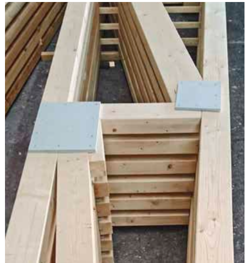
▲ Die Abdeckung der Nagelplatten mit maßgenau zugeschnittenen Gipsfaserplatten auf den auf Abbrand bemessenen Binderhölzern stellt eine weitere Brandschutz-Alternative dar
