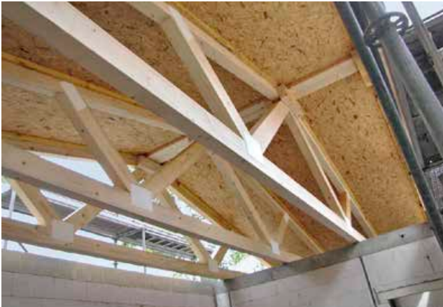
▲ Binder mit Brandschutzausstattung: Die sichtbaren Pads werden nach dem Einpressen der Nagelplatten aufgelegt und umlaufend auf das Holz geklammert
