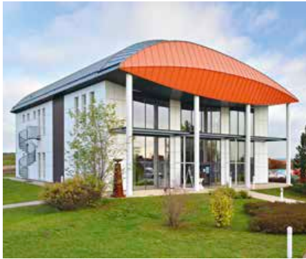
▲ Voluminöse Fischbauchbinder kamen hier bei einem Handelsunternehmen zum Einsatz
