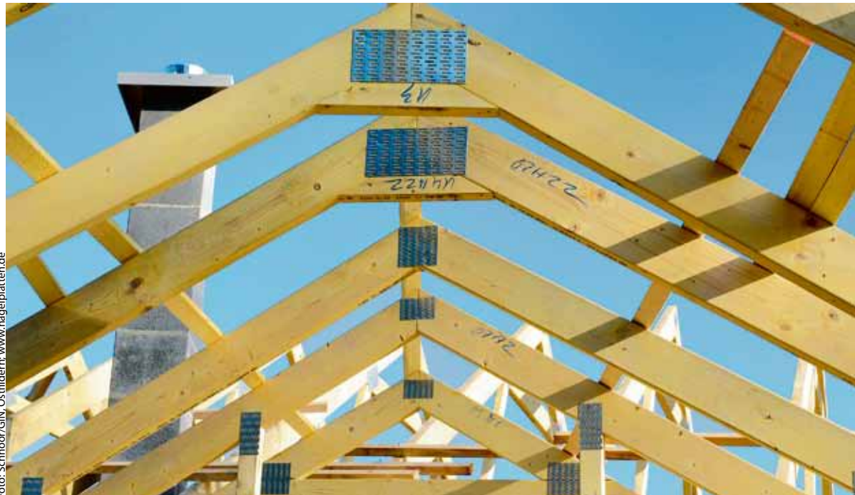
Nagelplattenbinder werden eindeutig gekennzeichnet, damit die Reihenfolge ihrer Montage auf den Umfassungswänden des Gebäudes klar ist.
