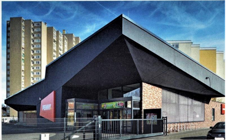
Das Dach zieht den Betrachter förmlich in den Verbrauchermarkt hinein - konstruiert aus Nagelplattenbinder.
