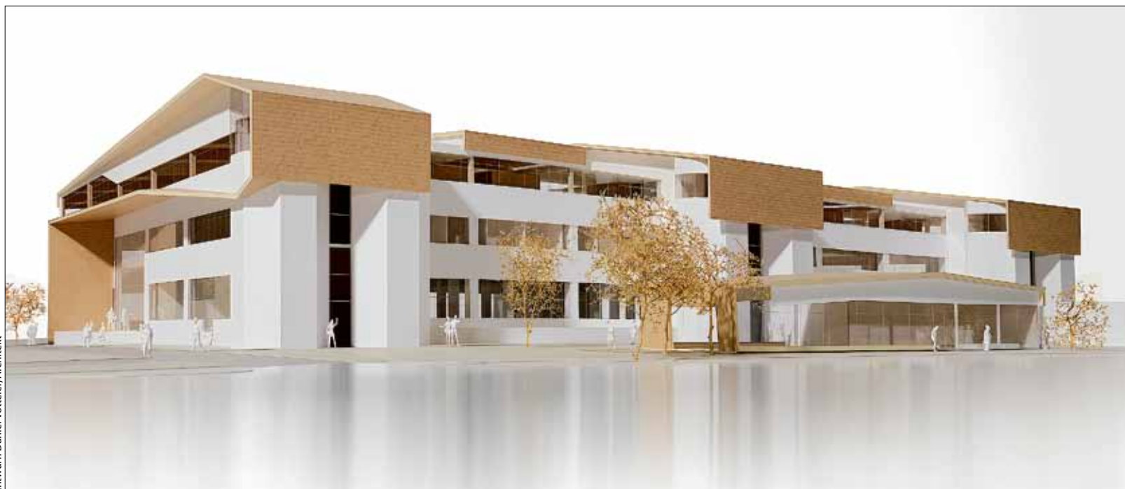
Holz über Beton: Charakteristisch für das TM50 sind die übergelegten Holzdächer mit ihren weit auskragenden Überständen, die die vorhandenen Bestandsdachflächen überlagern.
