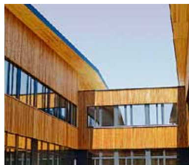
Innenhofgestaltung: Die Fassaden der vier Innenhöfe des TM50 wurden mit Lärchenholz bekleidet. Foto: HU-Holzunion
