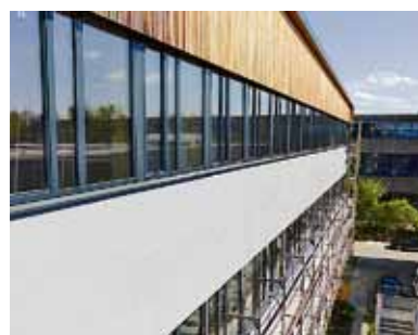
Attraktiv auf ganzer Fläche: Auf der Altfassade wurden Holzfaserdämmplatten vom Typ Inthermo HFD-Exterior Compact montiert, im System verputzt und in einem aparten Grauton attraktiv gestrichen. Foto: Achim Zielke
