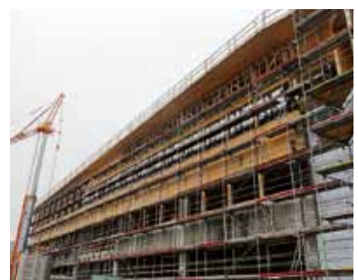
Dämmen mit Holz: An den Außenwänden des TM50 wurde das vierzigtausendfach bewährte INTHERMO Holzfasers-WDVS auf einer Fläche von 1.200 m 2 fachgerecht montiert. Foto: HU-Holzunion
