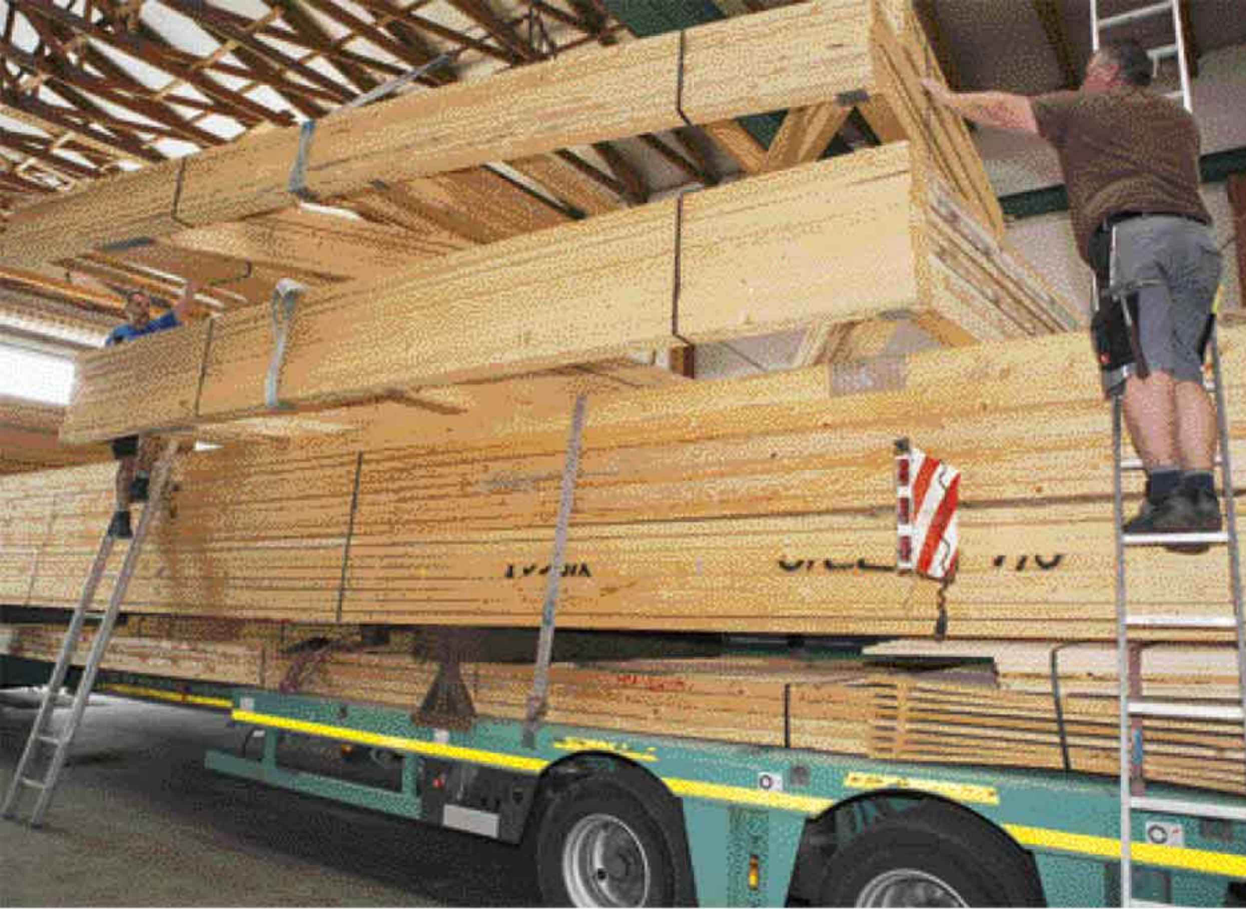
Die GIN-Mitgliedsunternehmen liefern Nagelplattenbinder richtfertig auf die Baustelle
