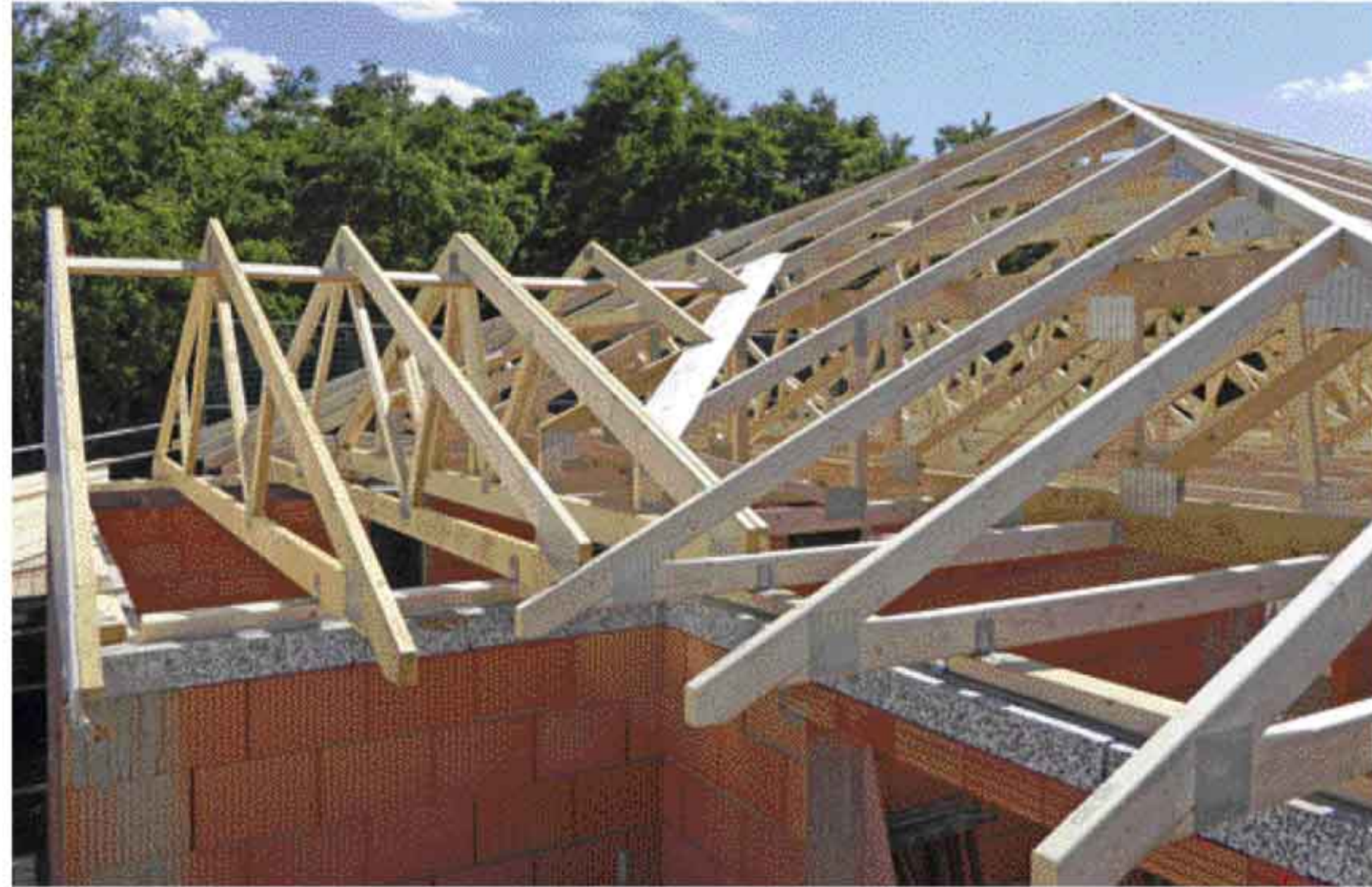
Aus einer Hand: Ambitionierte Betriebe können das Dach auch als Komplettleistung anbieten
