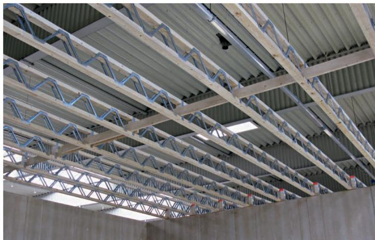
Besonders wirtschaftliche Geschossdeckenkonstruktionen lassen sich aus Parallelträgern mit Nagelplattenstegen herstellen
